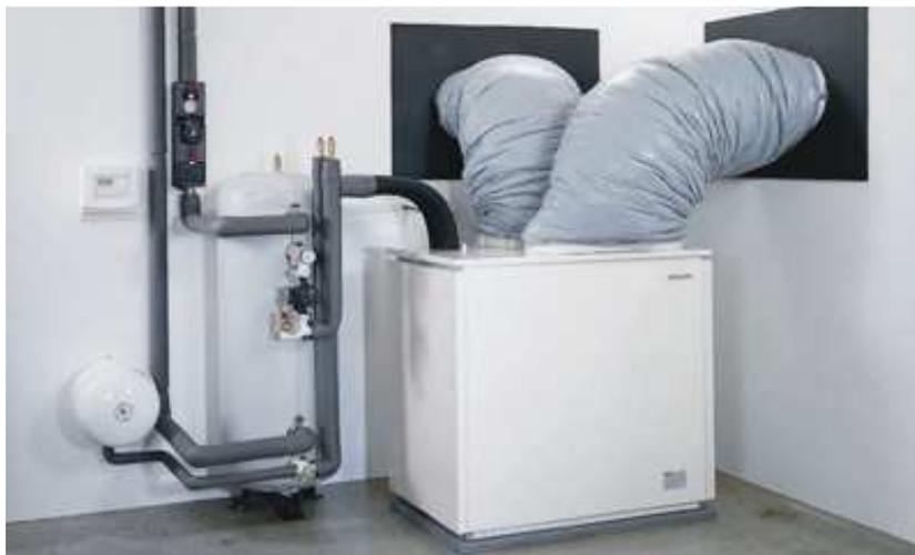
Abbildung 3: Luft/Wasser-Wärmepumpe innen aufgestellt
