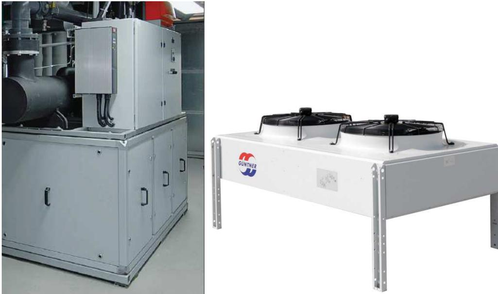
Abbildung 6: Luft/Wasser-Wärmepumpe innen aufgestellt mit Sole-Zwischenkreis-Rückkühler
